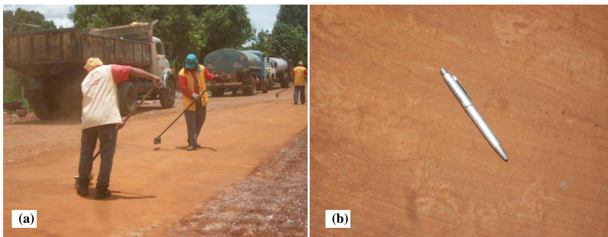
Figura 4.17 – Tratamento das trincas: (a) Varrição da camada de base; (b) Aspecto da camada depois varrição.
