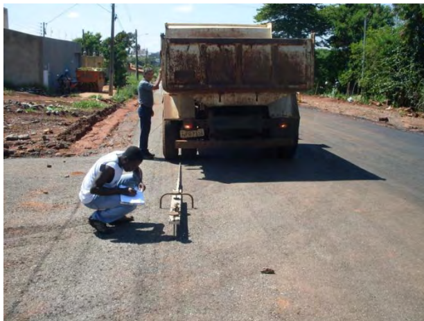
Figura 4. 22 - Execução do ensaio da viga Benkelman sobre o revestimento.
