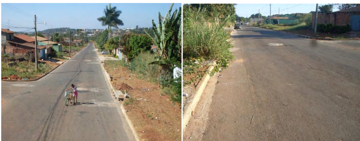
Figura 4.19 - Configuração final do trecho seis meses após sua construção.
