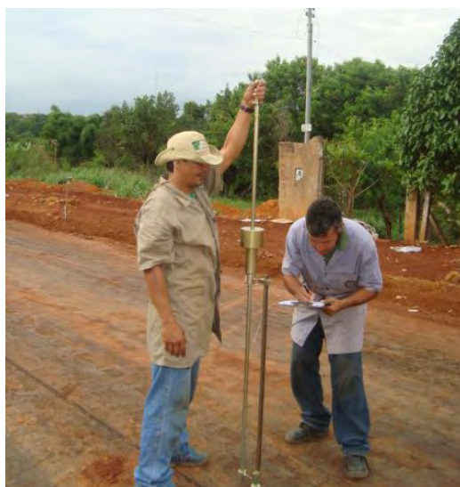
Figura 4.24 - Execução do ensaio DCP no subleito.
