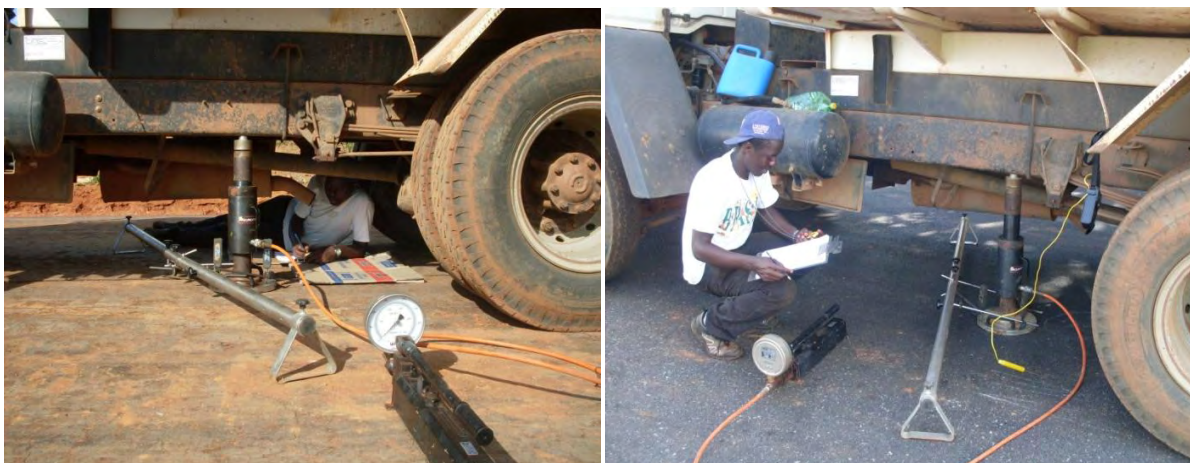
Figura 4.23 - Execução do ensaio de prova de carga estática; (a) Sobre o subleito; (b) Sobre o revestimento.
