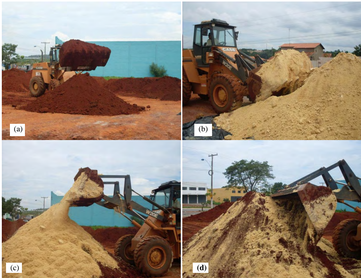
Figura 4.14 - Diferentes etapas da mistura do solo com o fosfogesso.
