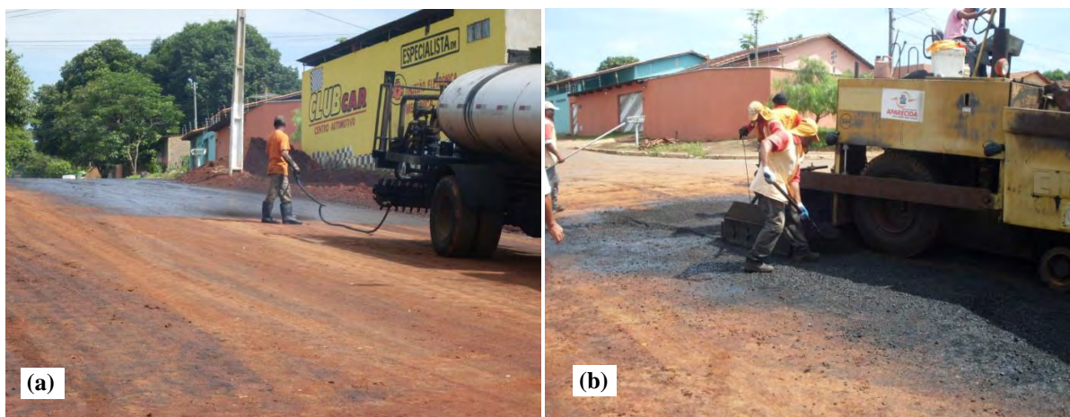
Figura 4.18- Execução do revestimento: (a) Imprimação da base; (b) Aplicação do revestimento.
