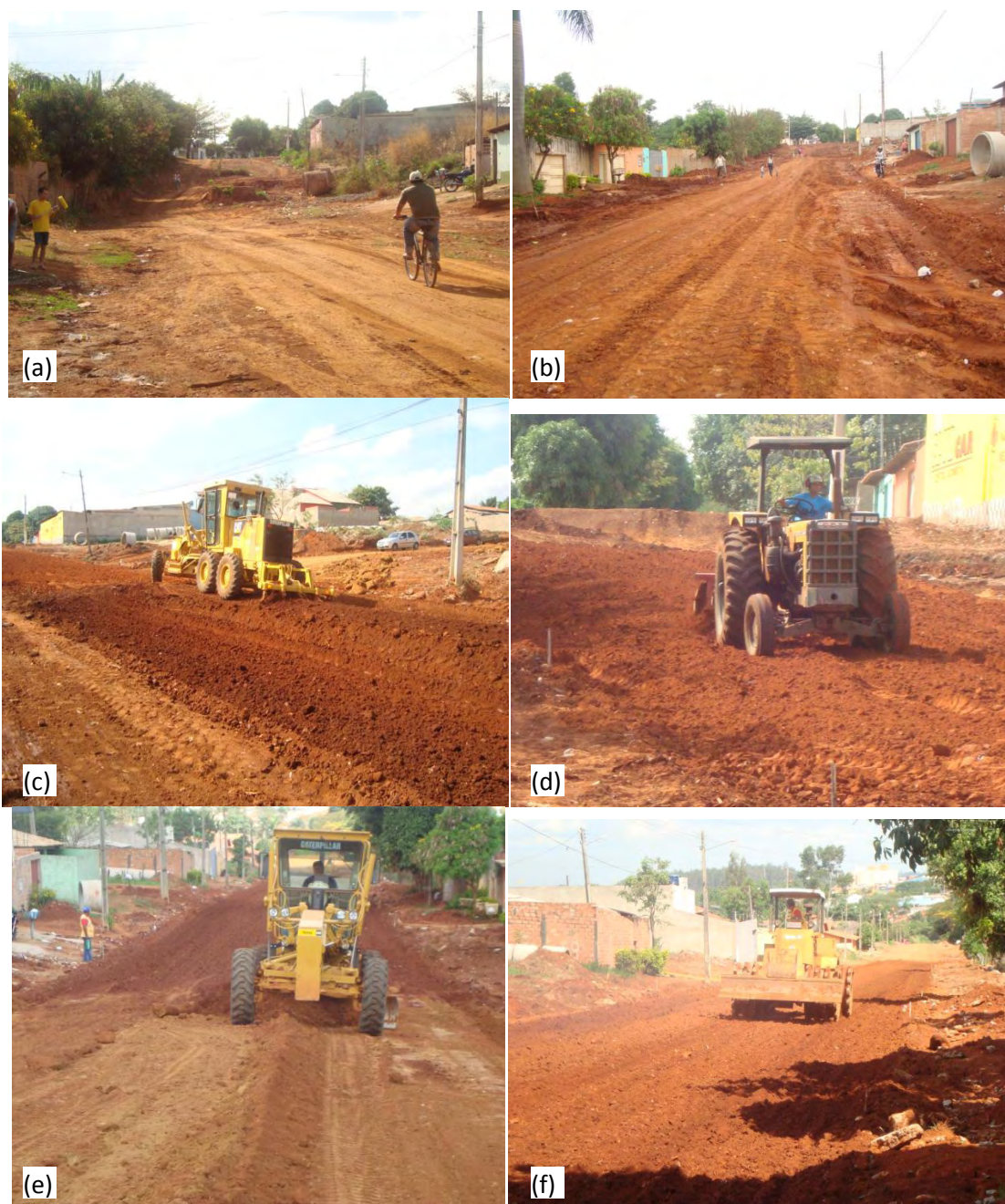
Figura 4.12 – Execução do subleito: (a) Pista no início do projeto; (b) Pista depois da remoção dos materiais não apropriados; (c) Escarificação da superfície do subleito; (d) Homogeneização dos materiais; (e) Distribuição do material na largura do trecho; (f) Compactação.
