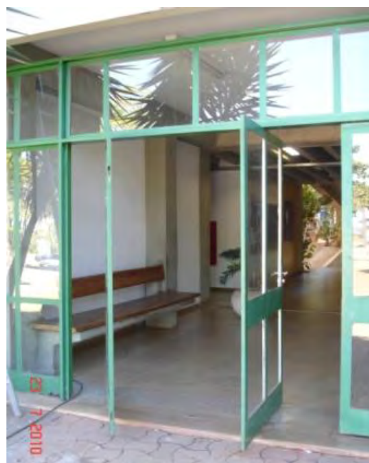
Figura 4.48 – Portas pivotantes, fáceis para a manutenção
