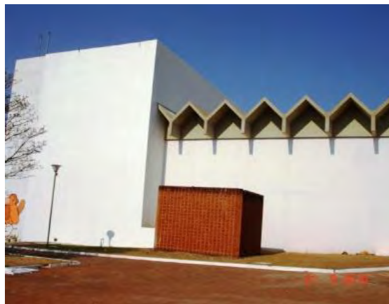
Figura 4.55 – Lajes inclinadas foram mantidas devido à composição da fachada
