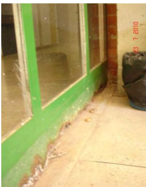
Figura 4.32 – Canto impossibilitado de limpeza com vassoura ou rodo.
