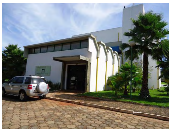
Figura 4.13 – Marcenaria transformada em Galeria de Artes, acréscimo da marquise
