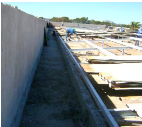
Figura 4.36– Substituição do telhado
