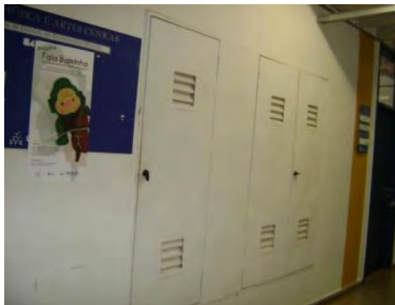
Figura 4.54—Shafts para as instalações do edifício
