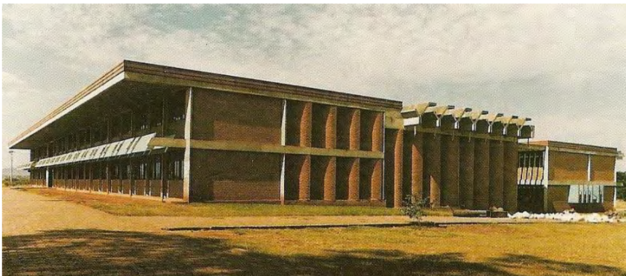
Figura 4.7 – Composição de fachada, lajotas e brises soleils (ZIMBRES,1993)
