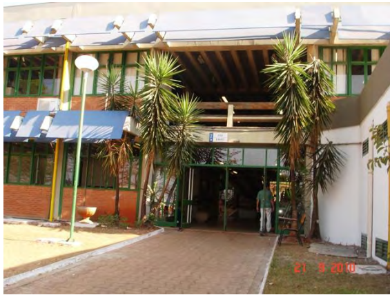
Figura 4.14– Eliminação do pé direito duplo e acréscimo de laje para dar acesso a ambientes do piso superior
