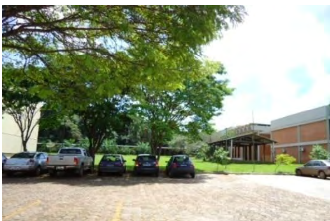
Figura 4.77– Proximidade do estacionamento ao prédio
