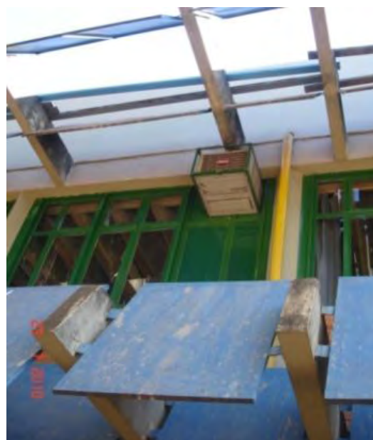
Figura 4.25 – Brises soleils confeccionados com material de baixa qualidade
