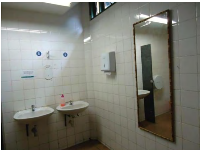
Figura 4.86 - Aparência atual dos sanitários
