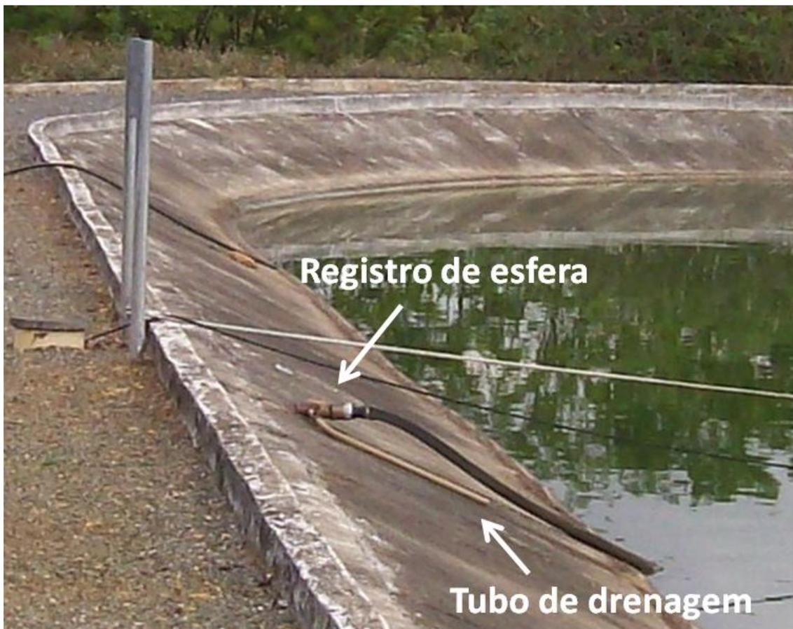
**Figura 12** Tubo de retorno da linha principal de bombeamento, utilizado para amostragem do esgoto bruto (afluente).
