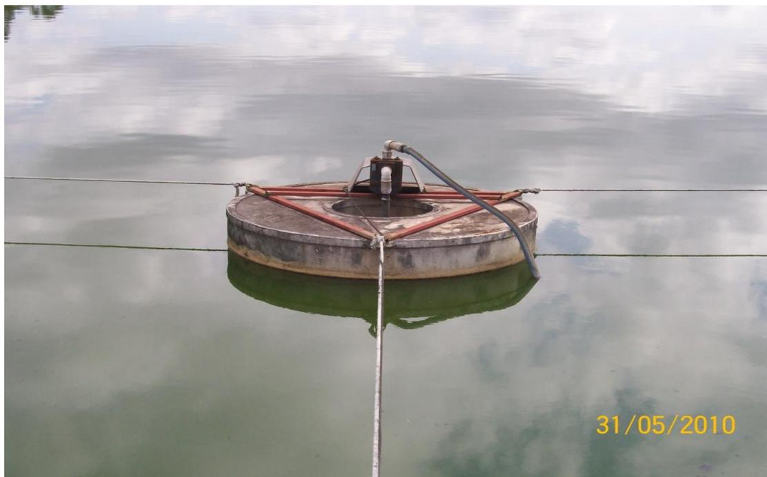
**Figura 8** Flutuador e bomba de captação do afluente para aplicação nos leitos de tratamento.
