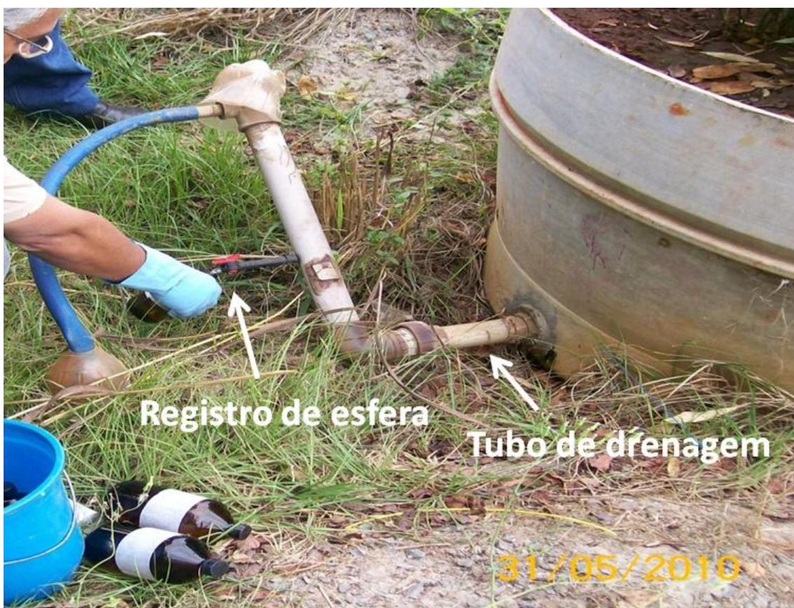
**Figura 11** Detalhe da utilização do registro de esfera na amostragem do esgoto tratado no leito de tratamento.
