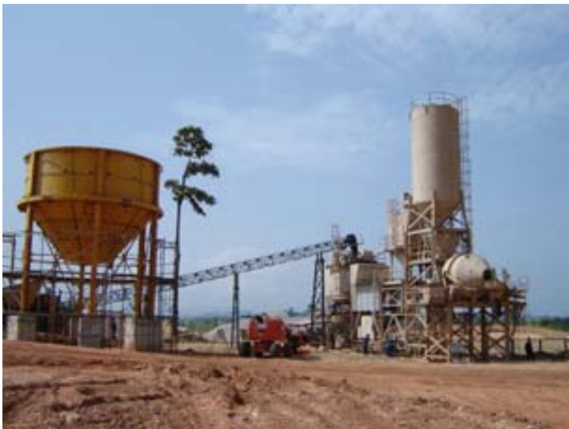
Ilustração 15 – Central misturadora instalada no canteiro de obra
