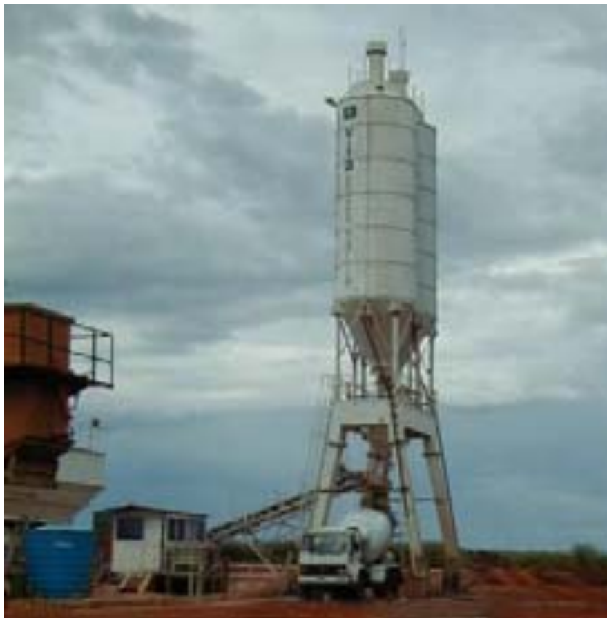
Ilustração 16 – Central dosadora com mistura caminhão betoneira
