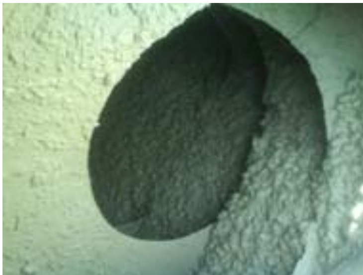
Ilustração 8 – Mistura do concreto dentro do caminhão betoneira.
