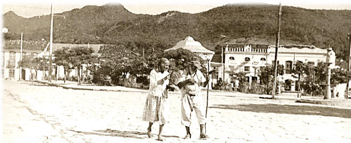
Fotografia 18 – A praça do Coreto entre as décadas de 1940 e 1950. Autor desconhecido. Arquivo particular de Elder Camargo de Passos, concedido mediante autorização de uso.
