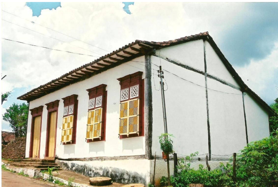
Figura 8 — Vista frontal e lateral da Casa do Capitão Francisco Pereira Ribeiro, em Pilar de Goiás (Atual Museu Casa da Princesa)
