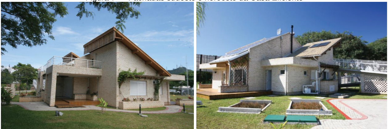
Figura 7 — Fachadas sudeste e noroeste da Casa Eficiente
