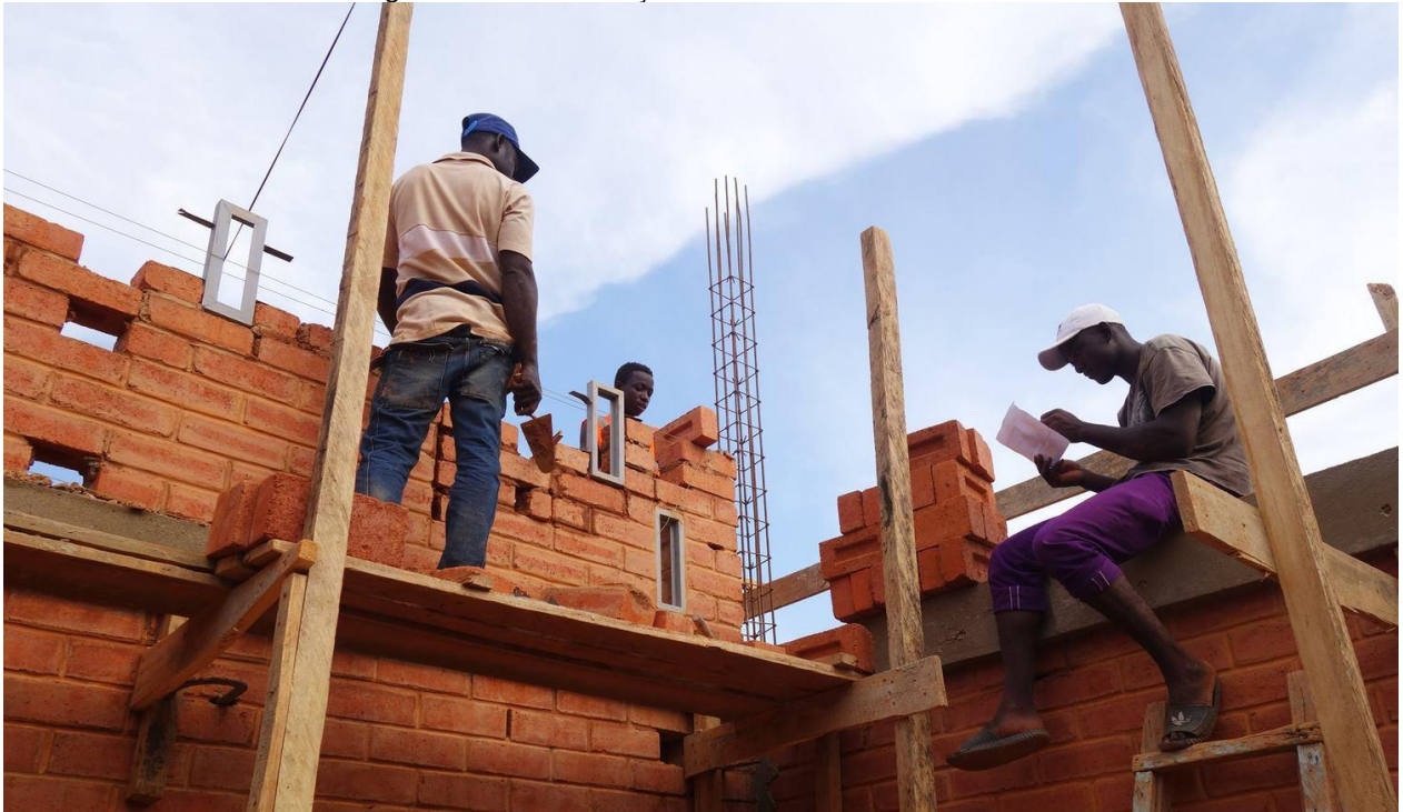
Figura 21 — Construção com bloco de solo-cimento
