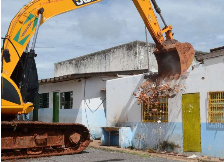
Figura 1: Demolição da UIPP.
