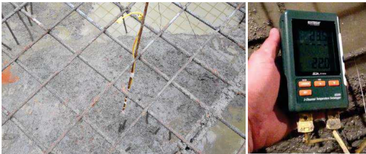
Figura 3.25 – Termopar instalado no bloco de fundação da obra monitorada
