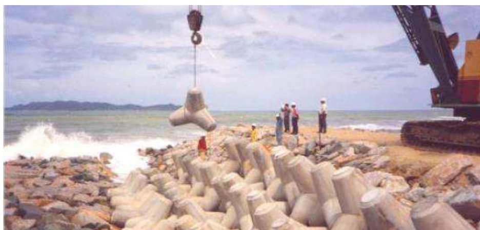
Figura 2.9 – Construção de um quebra-mar – colocação de tetrápodes (AZENHA, 2004).
