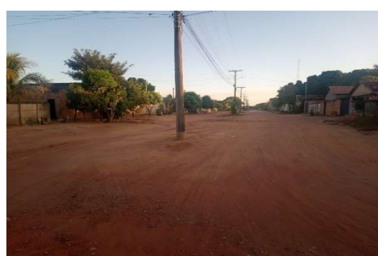
Figura 14 - Rua não asfaltada no Setor Vera Cruz em Britânia/GO, 2022
