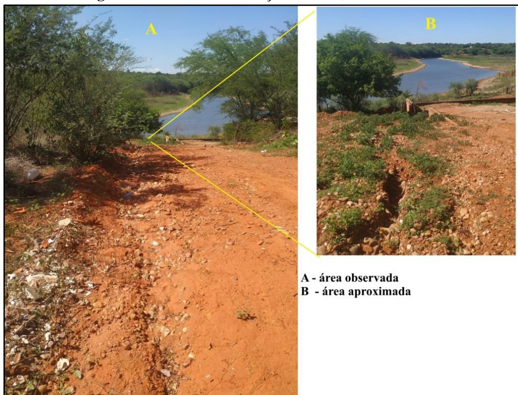
Figura 22: Área de Observação Ponto 1, Bairro Gavião.
