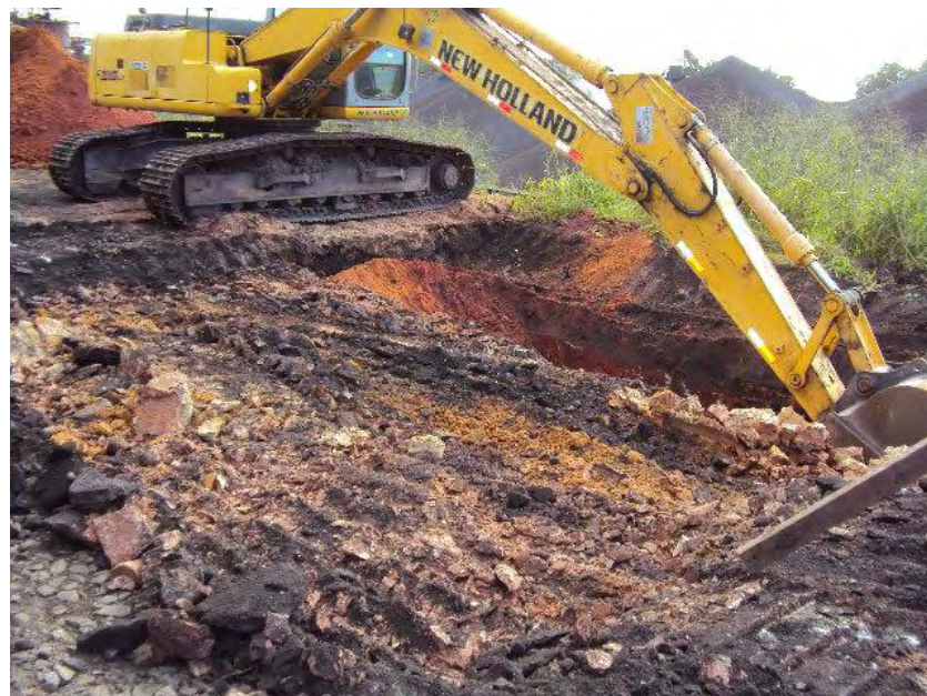
Figura 4.12 - Escavação com escavadeira
