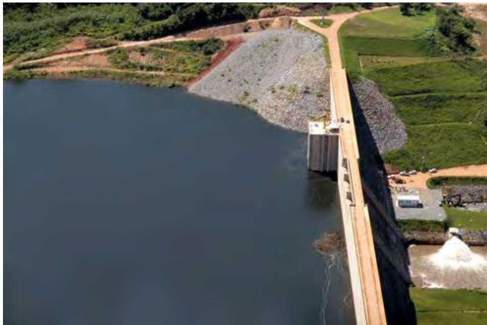
Figura 5.1 – Trecho da obra – Construtora - A
