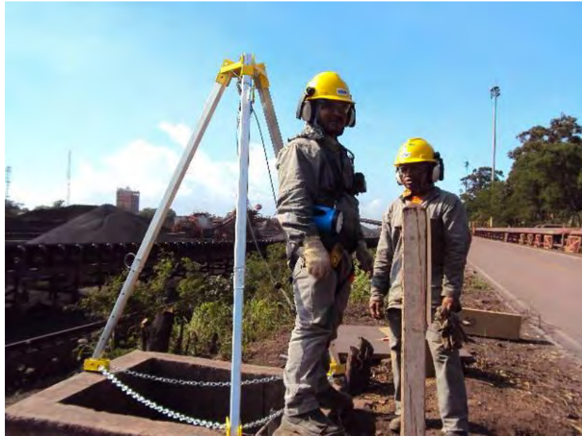
Figura 4.11 - Equipe preparada para inspeção em poço de visita
