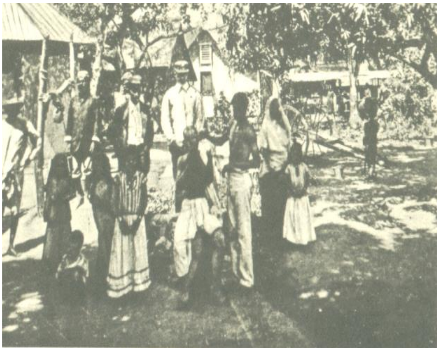
Figura 32 - Coolies em uma Plantation. In: The Trinidad Guardian Online Photo Gallery. Disponível em: http://www.guardian.co.tt/photos/details.php?image_id=1371 Acesso em 11 abr. 2007.
