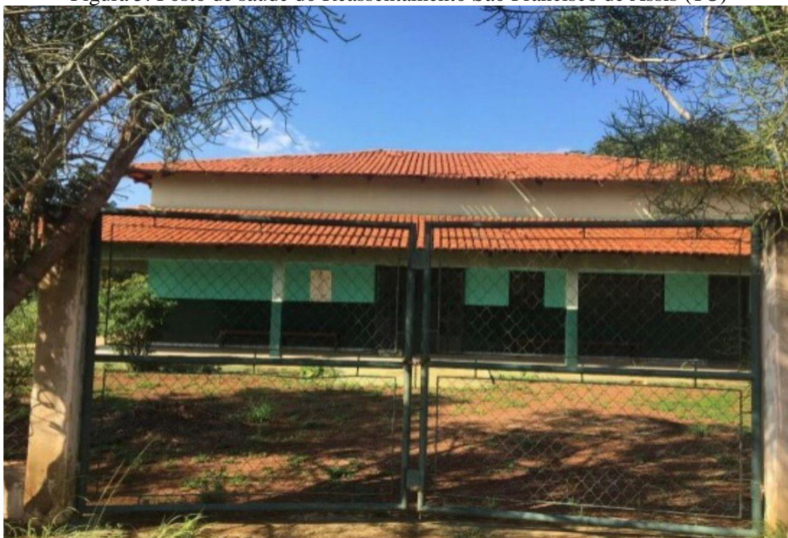
Figura 5: Posto de saúde do Reassentamento São Francisco de Assis (TO)
