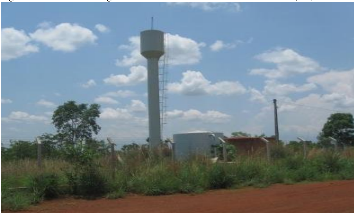
Figura 2: Reservatório de água do Reassentamento São Francisco de Assis (TO)
