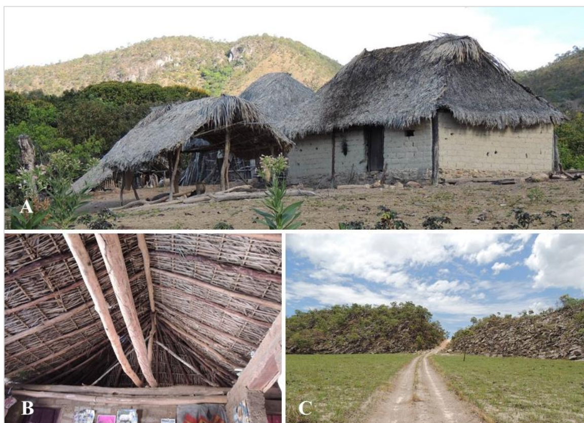
FIGURA 4– Moradias e via de acesso à Comunidade Kalunga, nos municípios de Cavalcante e Monte Alegre de Goiás, Goiás, Brasil. A: Casa de adobe e palha. B: Estrutura interna do teto de palha em casa de adobe. C: Estrada de chão aberta em meio à pequena serra para acesso às comunidades. Fonte: Rede Pró-Centro Oeste Curraleiro e Pantaneiro
