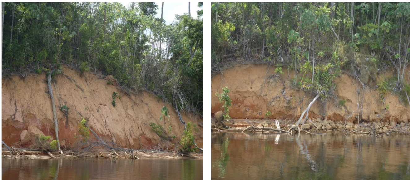
Figura 123 – Margem das ilhas da UHE Ferreira Gomes.
