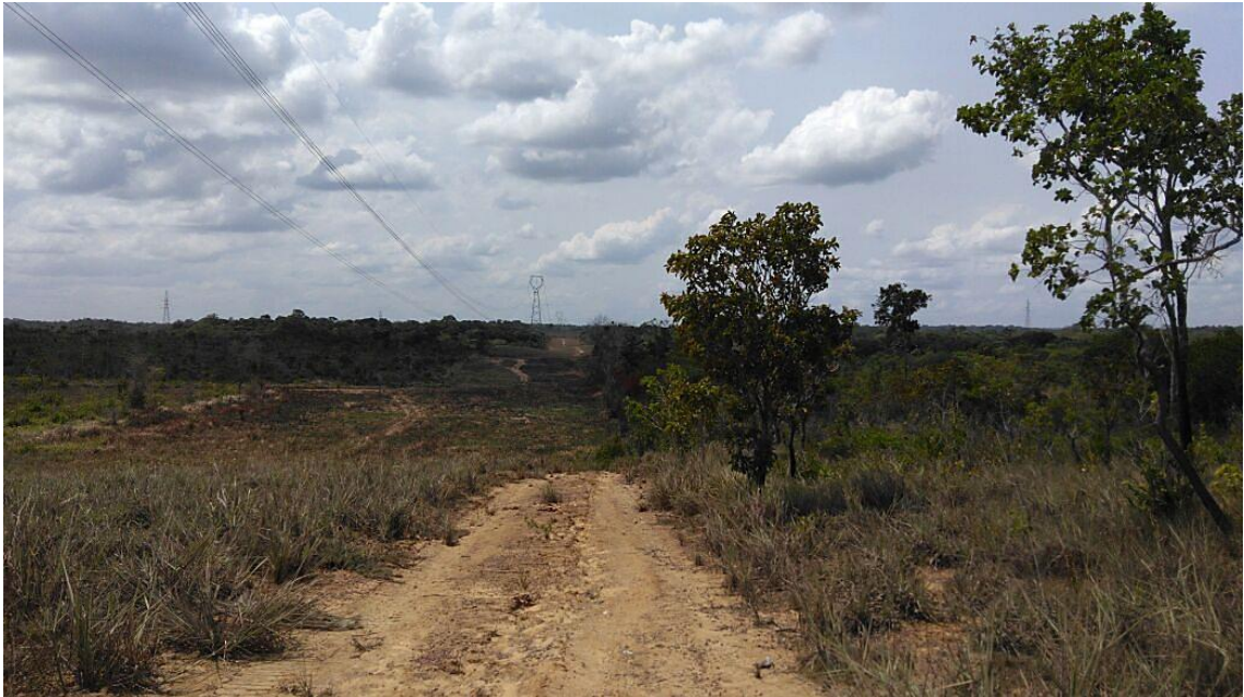
Figura 37 – Área que foi limpa para a passagem de linha de transmissão
