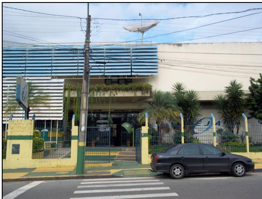
Figura 9: Instalações do Centro de estudo de Jovens e Adultos, Setor Universitário, Goiânia-Goiás, 2010.
