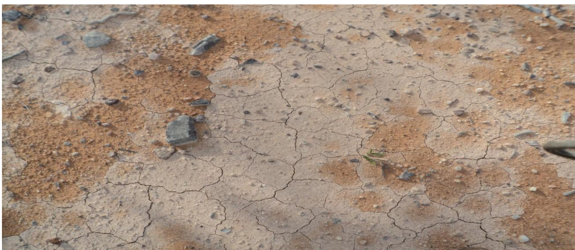
Figura 5.2. Fissuras no solo, ocasionado pelo ciclo de umedecimento e secagem do solo em recuperação, em Barro Alto, GO.
