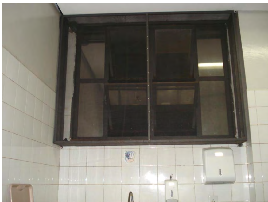
Foto 7 – Janela aberta com tela de proteção (H2)
