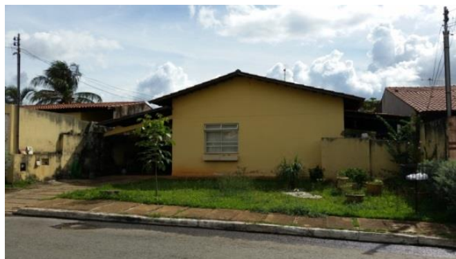
Figura 34: Edificação com fachada simples. Fonte: Acervo da autora.
