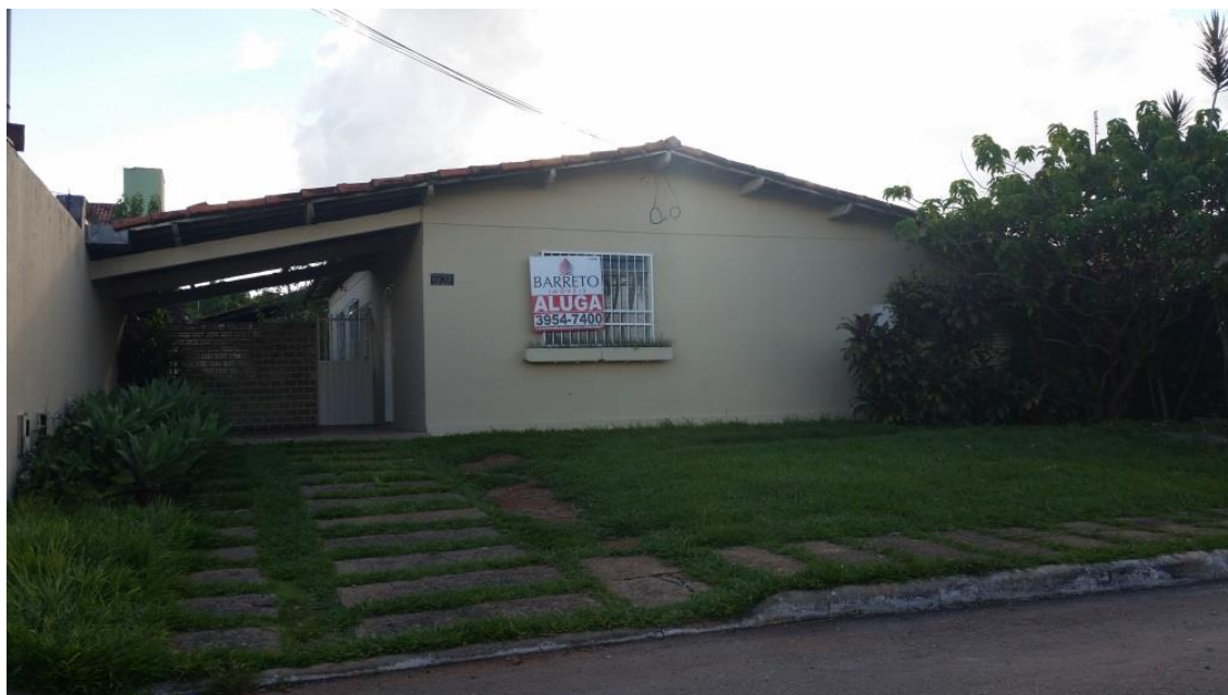
Figura 46: Edificação sem fechamento frontal. Fonte: Acervo da autora.
