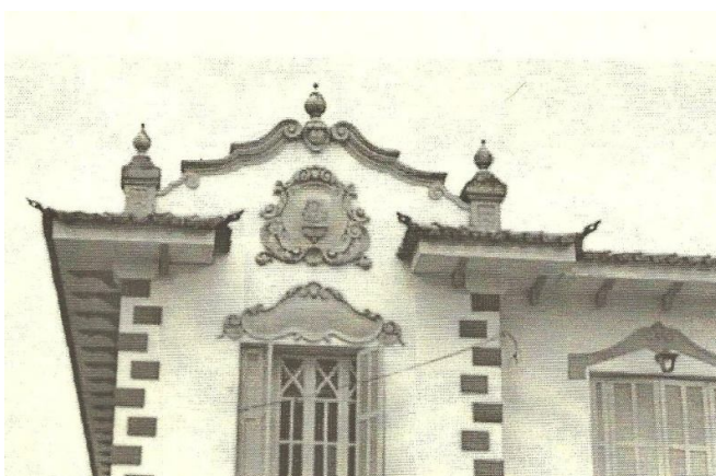
Detalhes da parte superior. Fonte: MELLO, 2002.
