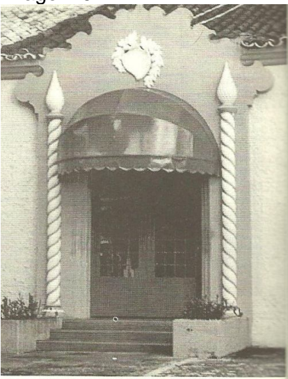
Detalhes da porta de entrada. Fonte: MELLO, 2002.
