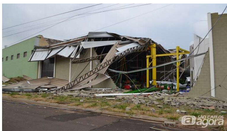
Figura 36 — Barracão destruído pelo vento em Matão
