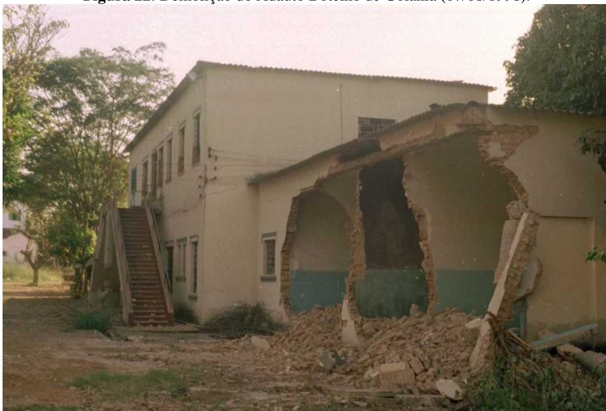
Figura 22: Demolição do Aduino Botelho de Goiânia (07/08/1998).
