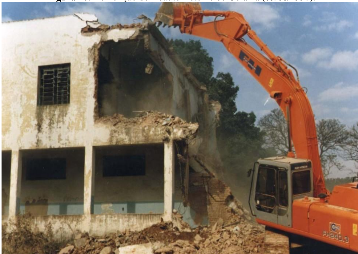
Figura 20: Demolição do Aduino Botelho de Goiânia (05/08/1997).
