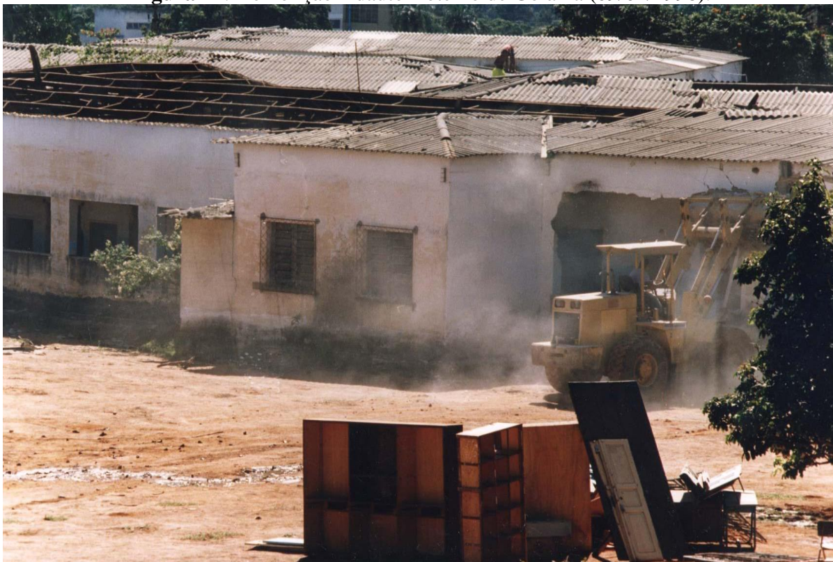
Figura 21: Demolição Aduino Botelho de Goiânia (09/01/1998).
