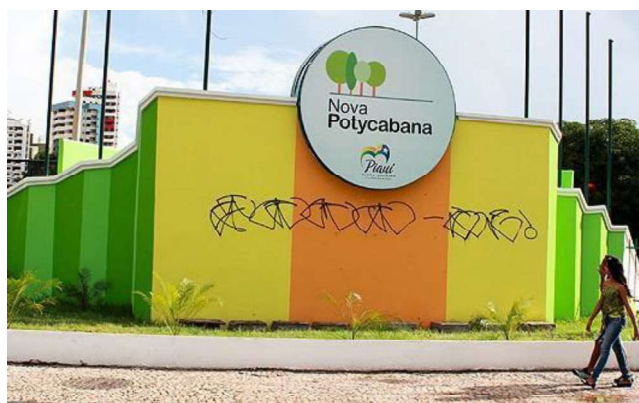
Foto 25: Pichação no Portal do Parque Nova Potycabana Fonte: Portal O Dia.com , Teresina, 05 jun.2013.
