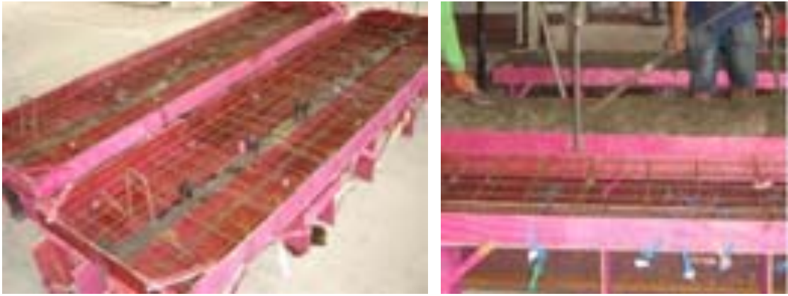
Figura 3.10 – Formas das vigas mistas e execução da concretagem
