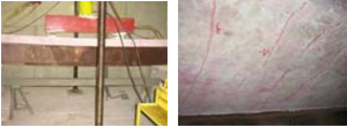
Figura 4.17 – Configuração geral após o ensaio e detalhe de fissuração do concreto das vigas V3A e V3B
