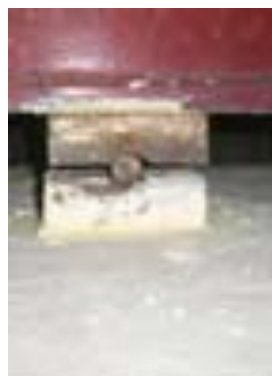
(b) viga de transmissão de carga e seus aparelhos de apoio de segundo e primeiro gênero
