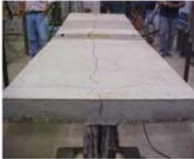
Figura 2.15 – Fissura longitudinal nas vigas mistas com laje treliçada – David (2003)
