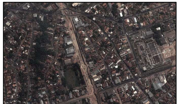
Figura 63: Trincheira Jurumirim em construção, 2013. Fonte: Disponível em Google Earth Pro.
