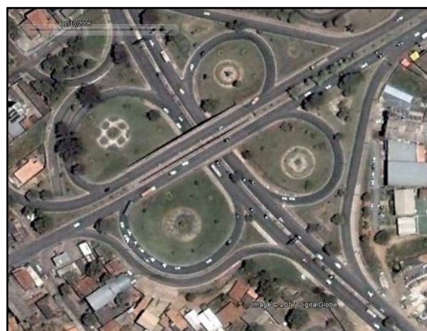
Figura 49: Imagem do viaduto da rodoviária da cidade de Cuiabá-MT em 2006. Fonte: Disponível em Google Earth Pro.
