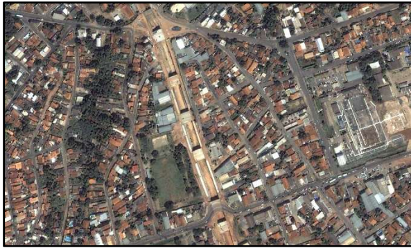
Figura 64: Trinchera Jurumirim em construção, 2014. Fonte: Disponível em Google Earth Pro.
