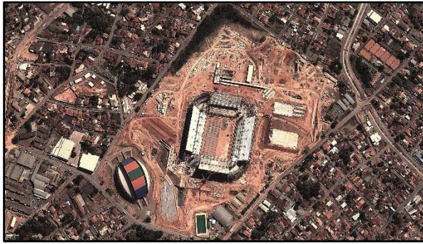
Figura 60: Arena Pantanal em construção, 2013. Fonte: Disponível em Google Earth Pro.
