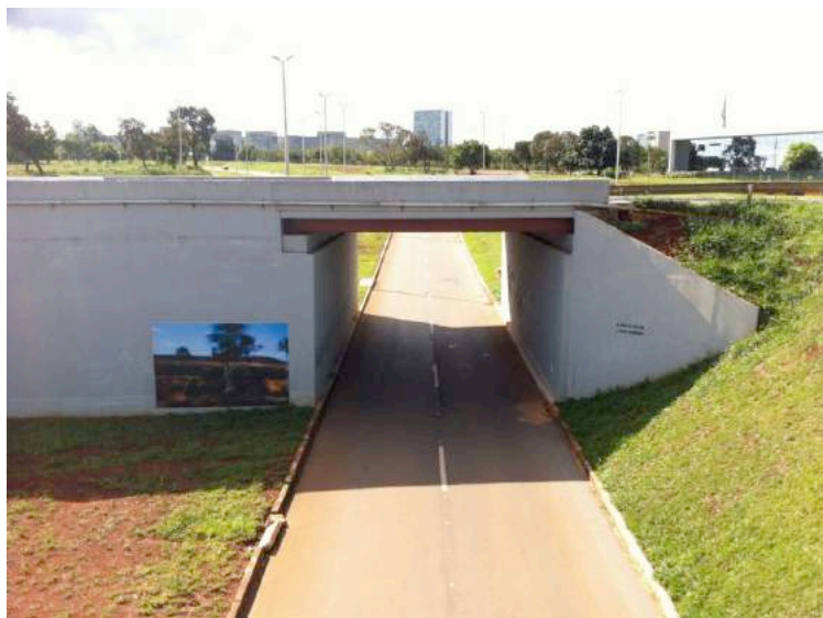
Imagem 12 – Intervenção no Viaduto do Setor de Administração – Brasília-DF (2013)
