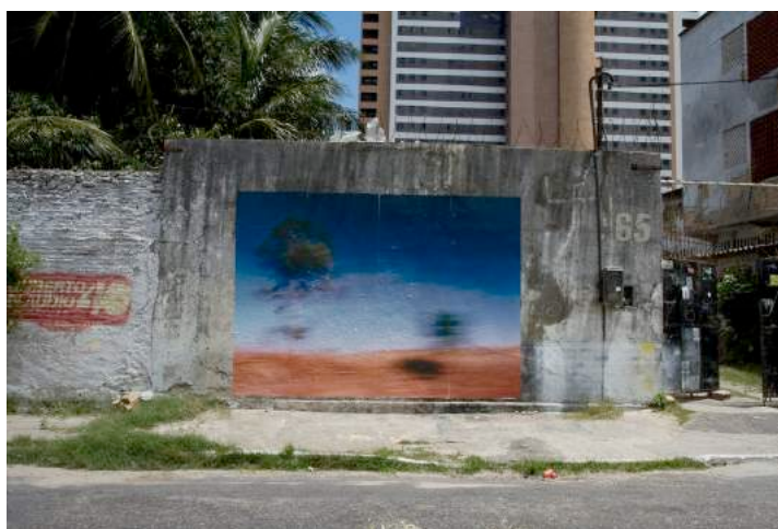
Imagem 8 – Intervenção na Rua José Avelino – Fortaleza-CE (2013)
