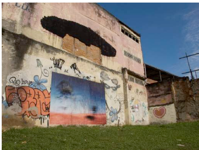
Imagem 7 – Intervenção no Catambi (embaixo do viaduto Santa Bárbara) – Rio de Janeiro-RJ (2012)
