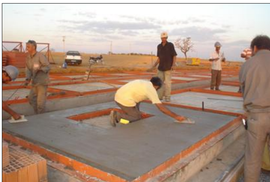
Figura 4-15 – Revestimento horizontal de argamassa. (Fonte: JAIME et al. , 2009)
