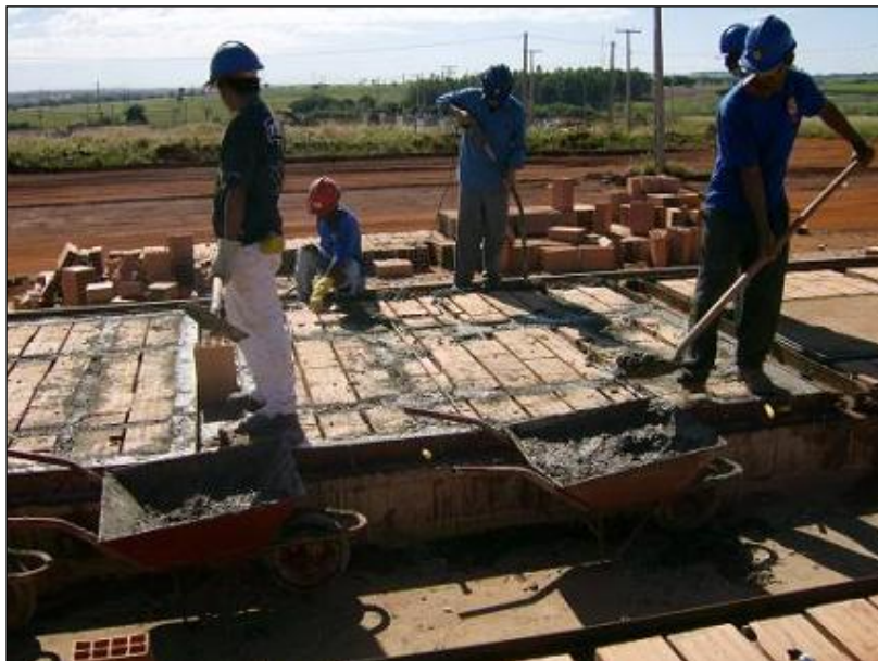
Figura 4-14 – Concretagem. (Fonte: JAIME et al. , 2009)
