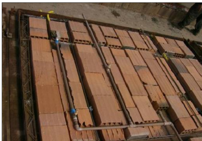
Figura 4-13 – Montagem dos kits de água fria. (Fonte: JAIME et al. , 2009)
