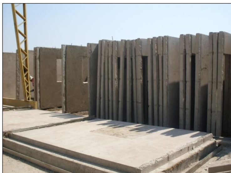
Figura 4-18 – Armazenamento dos painéis.
