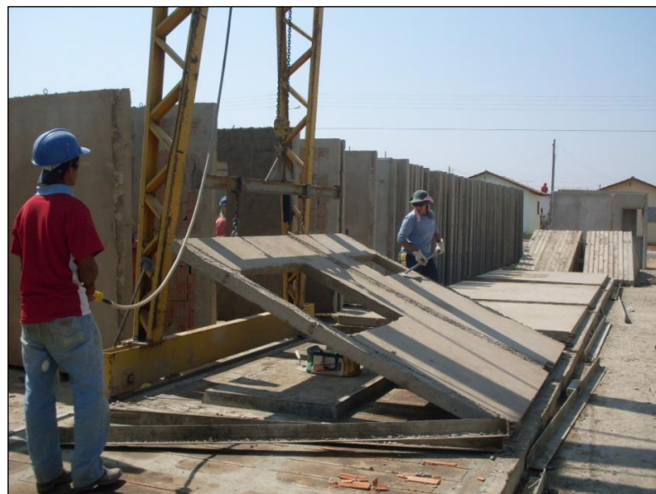
Figura 4-16 – Içamento dos painéis.
