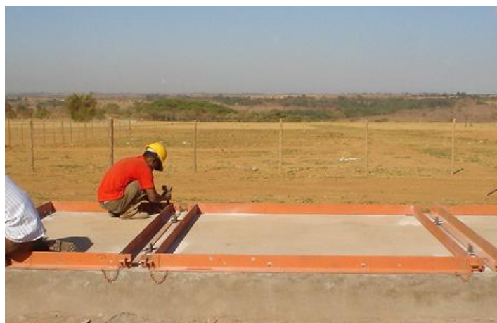
Figura 4-11 – Formas dos painéis. (Fonte: JAIME et al. , 2009)
