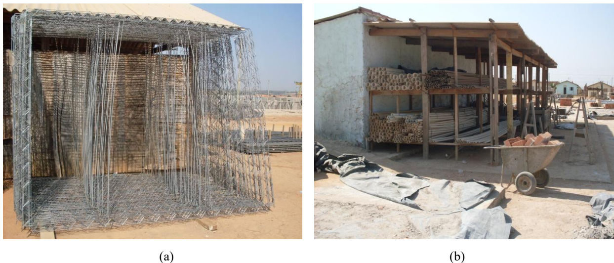
Figura 4-10 – Canteiro de obras. (a) Armazenagem das treliças de aço. (b) Armazenagem de tubos.
