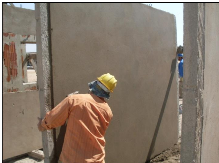
Figura 4-17 – Revestimento vertical de argamassa
