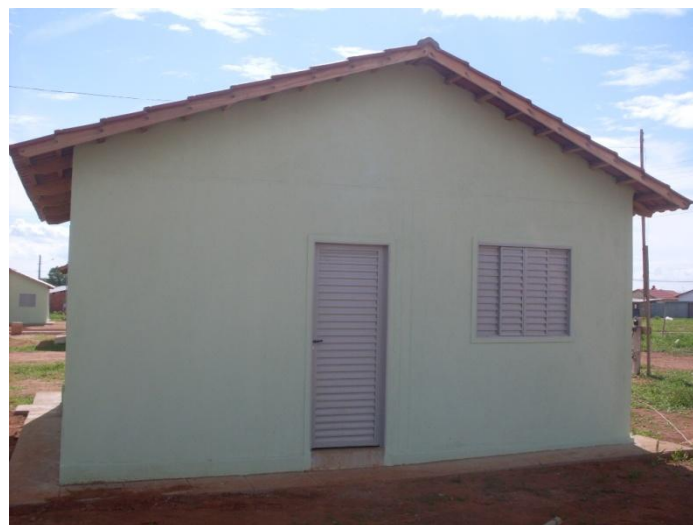
Figura 4-7 – Unidade habitacional finalizada no Residencial Real Conquista
