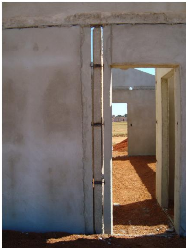
Figura 4-21 – Junção dos painéis. (Fonte: JAIME et al. , 2009)
