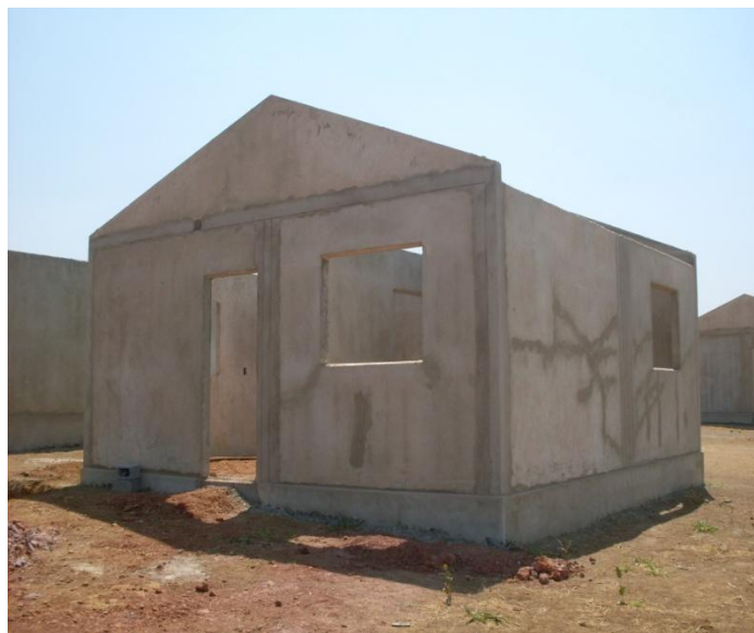
Figura 4-22 – Montagem dos painéis.
