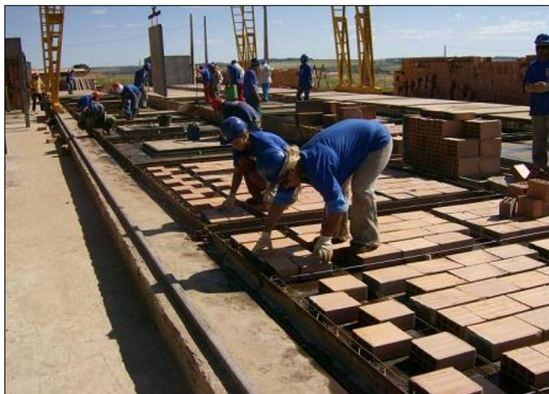
Figura 4-12 – Montagem dos blocos cerâmicos. (Fonte: JAIME et al. , 2009)
