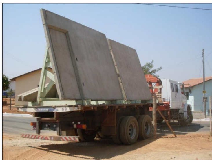
Figura 4-19 – Transporte dos painéis.
