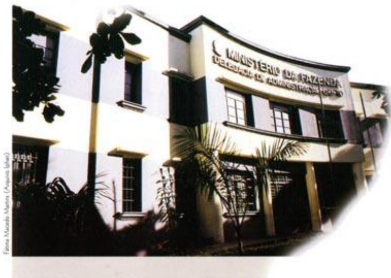
Figura 45. Fachada atual da construção. Livro Goiânia art déco.
