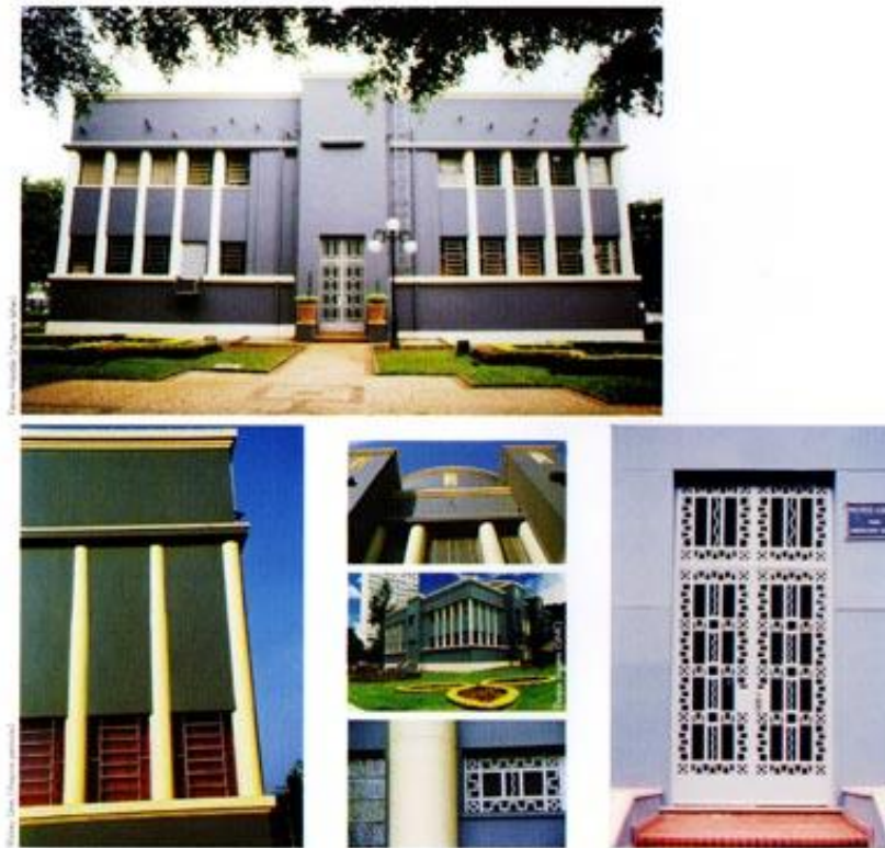
Figura 42. Detalhes e outros ângulos da construção. Livro Goiânia art déco.
