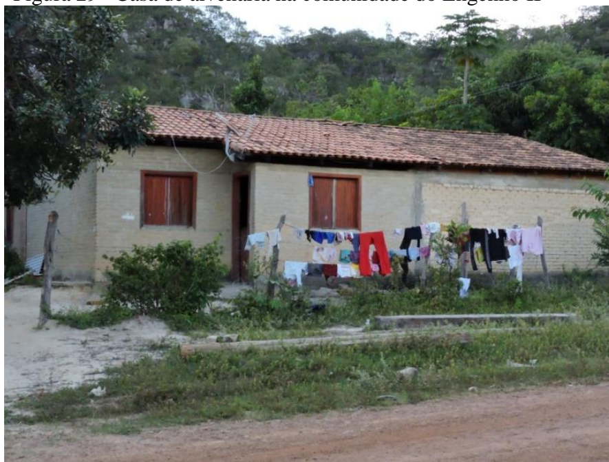
Figura 29– Casa de alvenaria na comunidade do Engenho II
