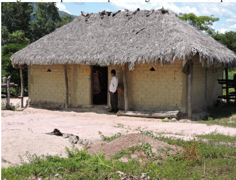
Figura 45– Típica construção Kalunga no Vão do Moleque
