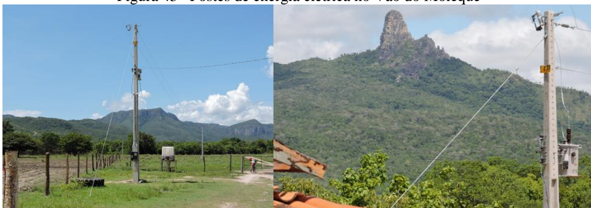
Figura 43– Postes de energia elétrica no Vão do Moleque
