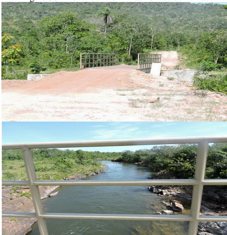
Figura 36 – Ponte do Rio Almas no Vão de Almas
