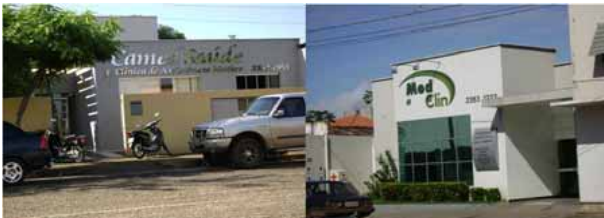
Figura 25: Clínica Camed Pediátrica localizada na Av. Luiz Leite Ribeiro e Clínica Med Clin, Otorrino, na Av. Anízio Alves Costa em Porto Nacional.
