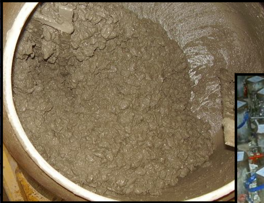
Figura 4.15 – Preparação de concreto na betoneira.
