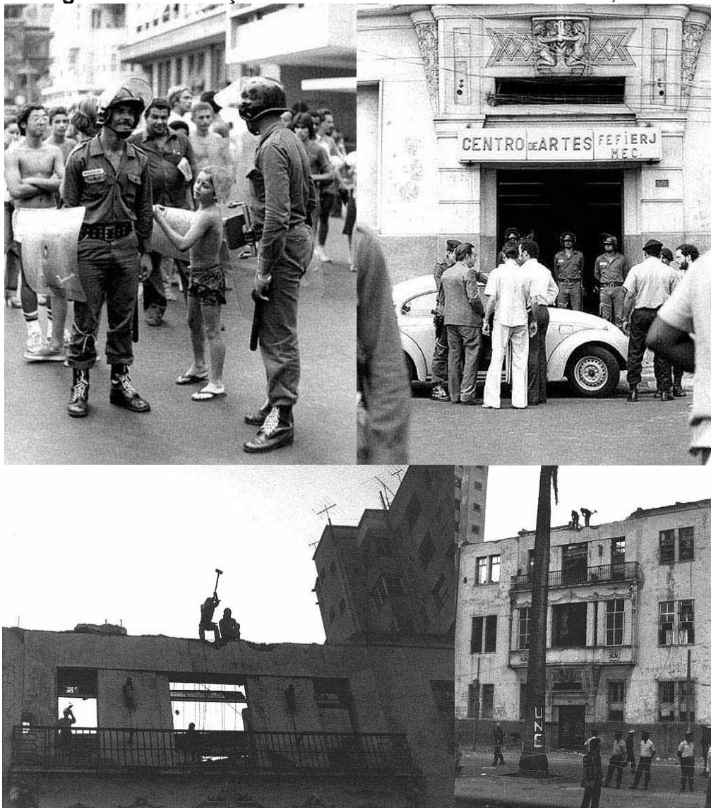
Figura 09: Demolição da Sede da UNE – Rio de Janeiro, 1980.
