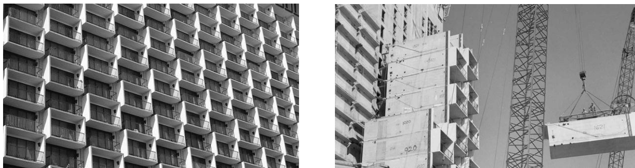
Figura 49, 49a – Hotel Palacio del Rio, San Antonio TX.
