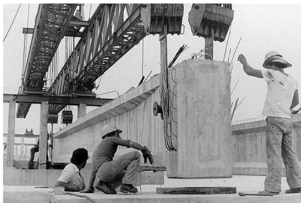
Figura 42 – Laços de Içamento
