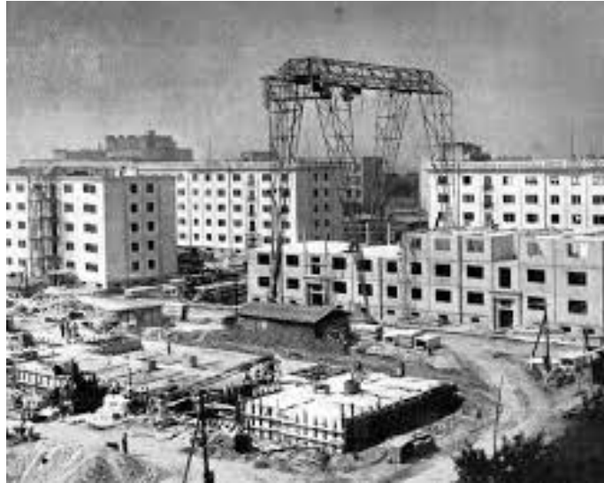
Figura 5 – Praga, Tchecoslováquia, 1956. Construção com grua de pórtico.
