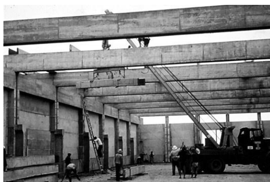
Figura 26 – REFAP em construção.
