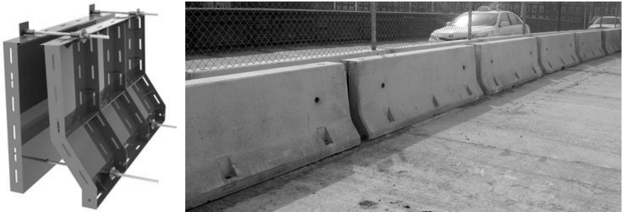
Figura 43,43a – Barreiras New Jersey: fôrma e premoldado
