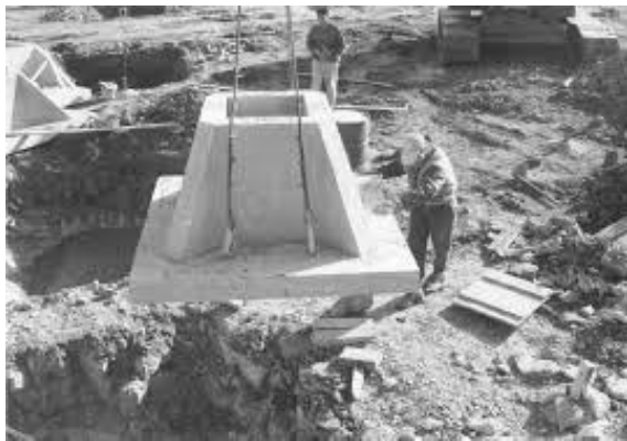
Figura 47 – Cálice de fundação
