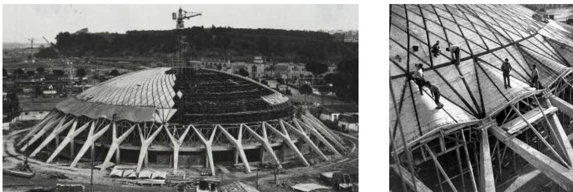
Figura 17,17a – Nervi. Palacio de Esportes de Roma em construção.
