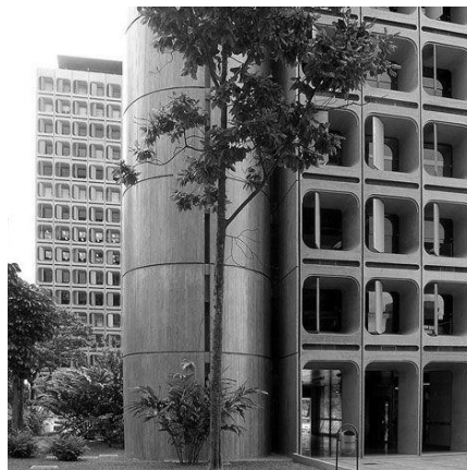
Figura 53 – Ed.Camargo Correa e o “núcleo” rígido moldado in loco .
