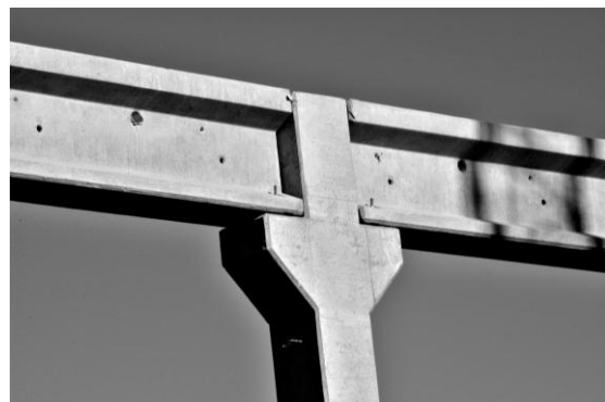
Figura 44a – Pilar com consolos e vigas
