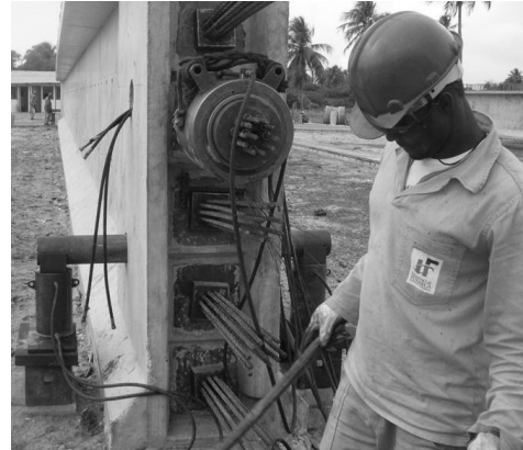
Figura 51a – Protensão após desfôrma
