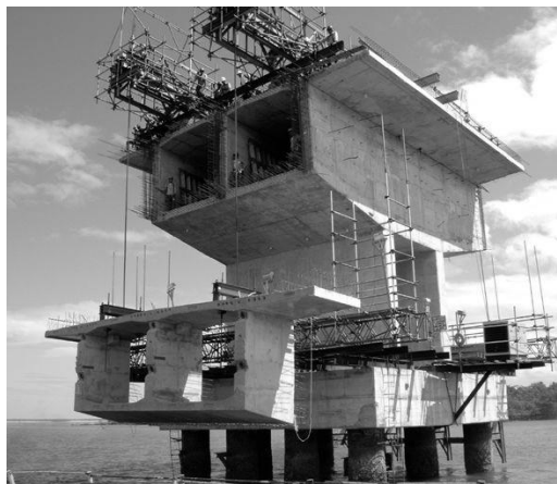
Figura 65 – Ponte em construção com aduelas.
