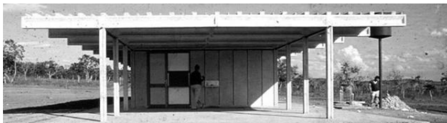
Figura 50 – Vigas isostáticas biapoiadas. Escola de Abadiania-GO.
