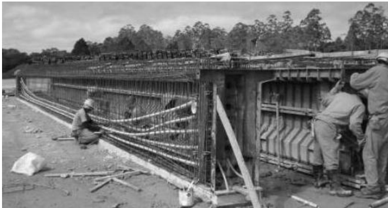
Figura 51 – Fôrma com cabos de protensão
