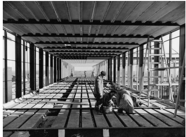
27a. Lajes pré-fabricadas em Hunstanton Fonte: driversofchange. Fotografia: E E Swain
