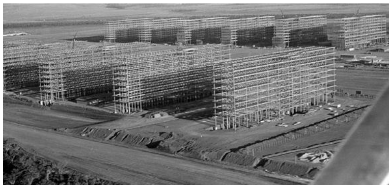
Figura 31 – Estruturas metálicas na Esplanada dos Ministérios
