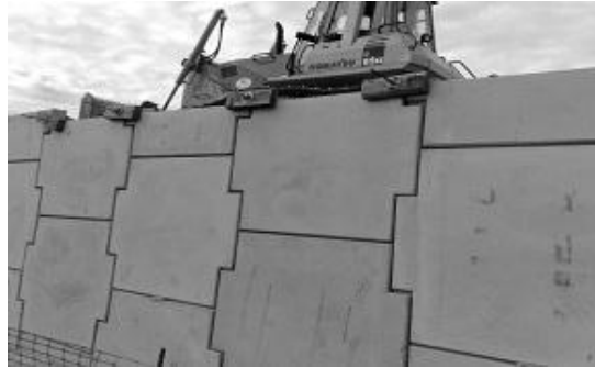
Figura 48 – Contenção em terra armada.
