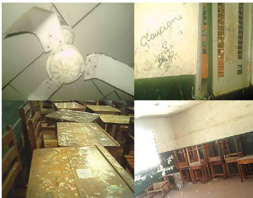
Figura 6. Registros das condições estruturais da Escola, 2008.
