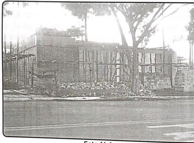
Foto 11-A Início da Construção do Teatro Juquinha Diniz
