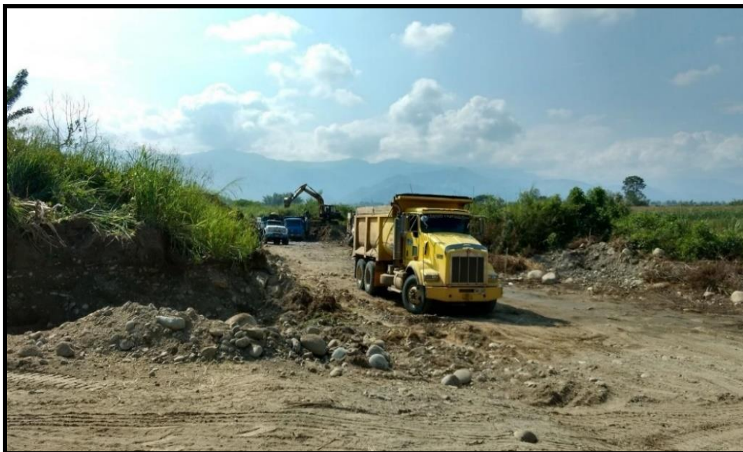
Foto 5 - Caminhões basculantes e retroescavadeira na extração de material de arrasto no
