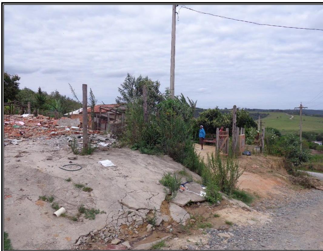
Foto 70 - Casas demolidas no Quilombo Cafundó/Brasil
