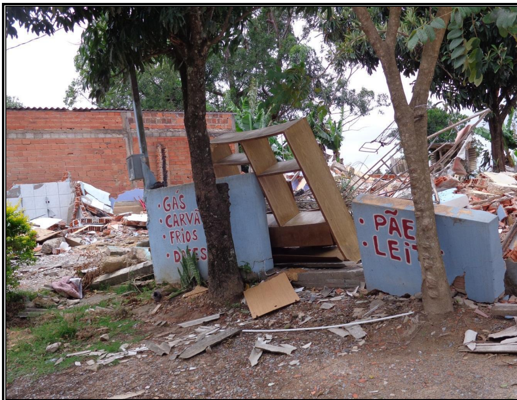
Foto 62 - Casas de posseiros demolidas no Quilombo Cafundó/SP
