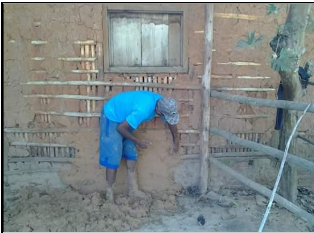
Foto 10 - Reforma da Casa de pau-a-pique no Quilombo Cafundó/SP
