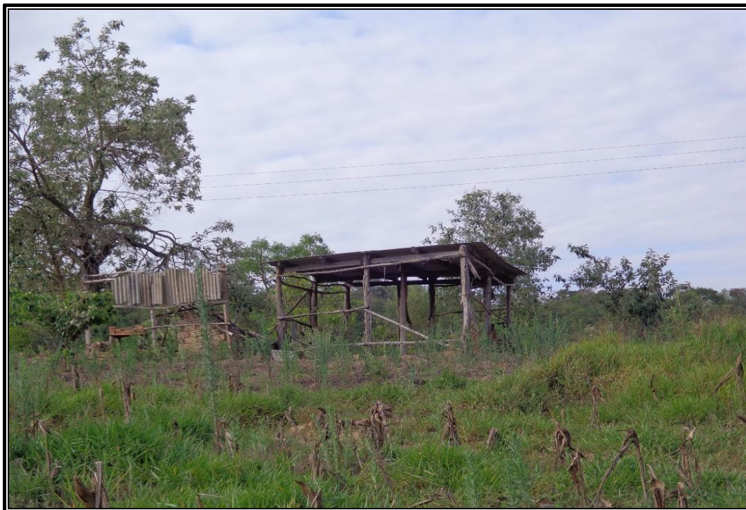
Foto 71 - Área C, estrutura dos barracos usados pelas famílias do Cafundó na ocupação, em 2008, Brasil
