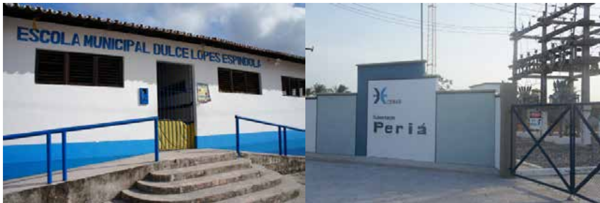
▲ PRANCHA 51 - Escola pública e subestação de energia elétrica. Fonte: arquivo da autora.
