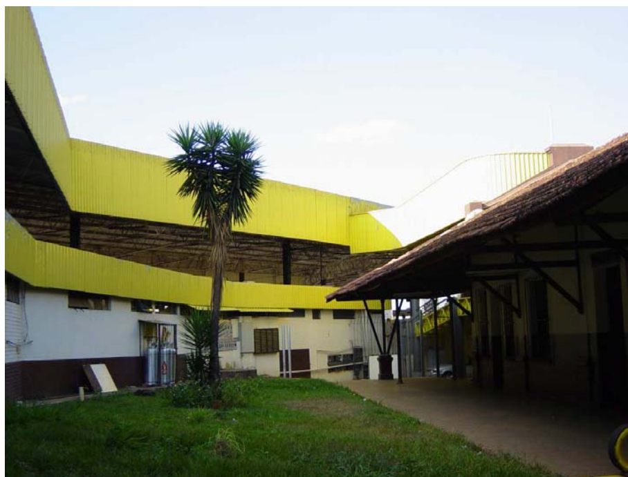
Figura 32 –Anápolis –Go: Terminal Urbano de passageiros.
