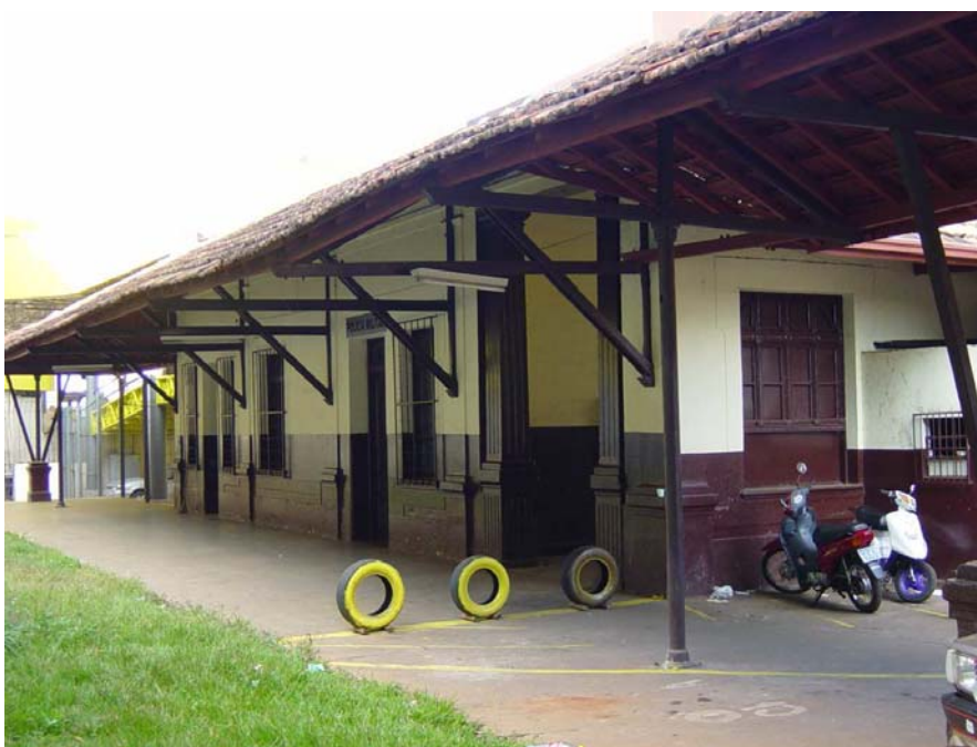
Figura 06 - Visão parcial da Estação Ferroviária
