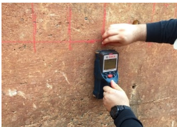
Figura 2.5 - Ensaio de pacometria para identificação de localização de armaduras (LEONEL; FRANÇA, 2019).
