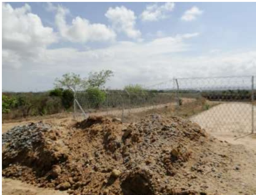
FIGURA 85: ÁREA DE OBRAS DA LINHA FÉRREA CERCADA.
