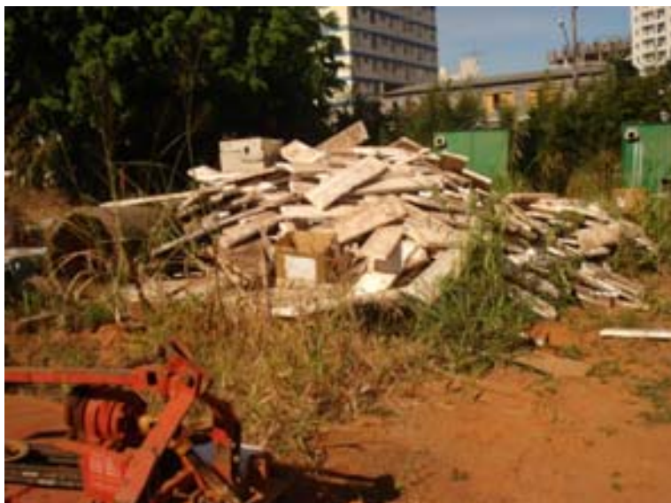
Figura 47 – Armazenamento inadequado de isopor
