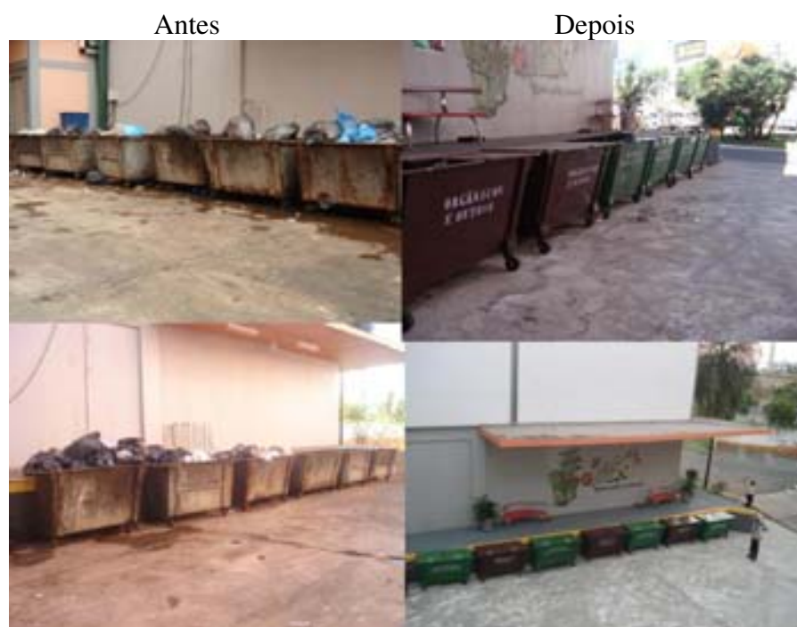
Figura 63 – Melhoria do Cais 3 após reforma
