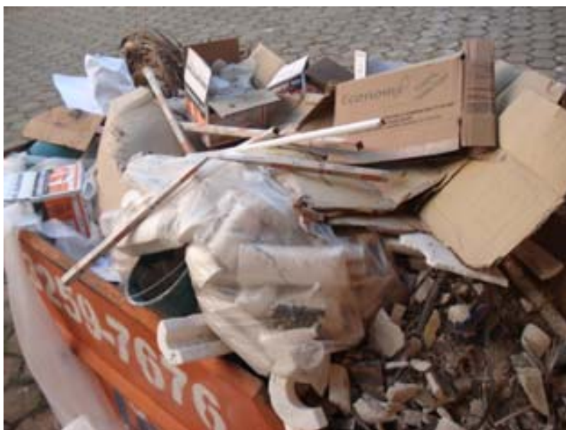
Figura 46 – Contêiner de resíduos de construção e demolição com outras classes de resíduos armazenados
