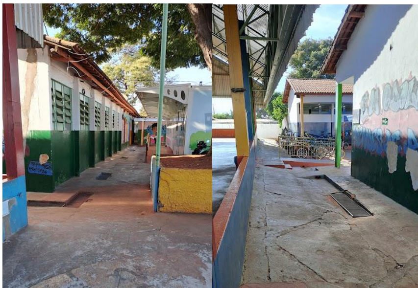
Figura 3 - Entrada da escola que dá acesso às salas de aula
