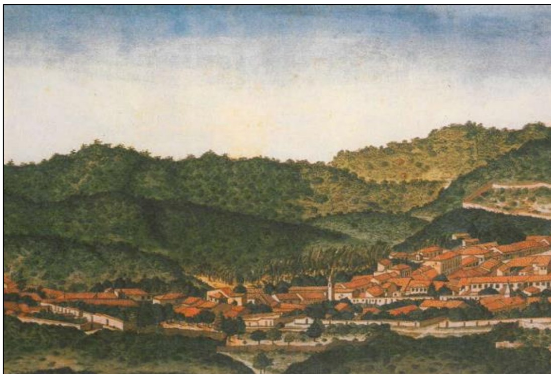
Figura 4 - Vista panorâmica de Vila Boa de Goiás (1803) - Torre e telhado da igreja Nossa Senhora do Rosário
