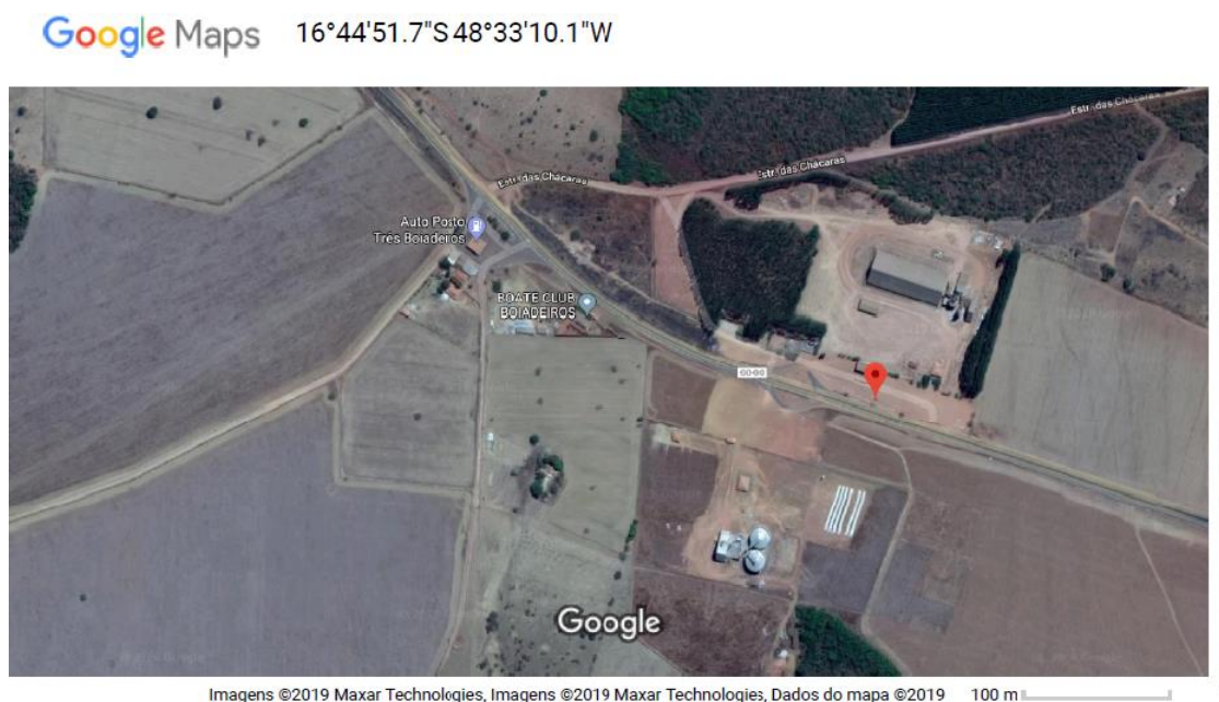
Fotografia 02. Centro de armazenagem da Multigrãos, próxima ao trevo de acesso à Vianópolis-GO
