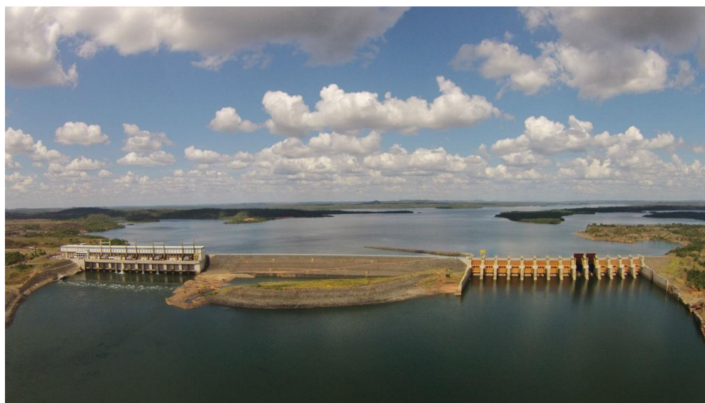
FIGURA 1 - UHE Estreito já instalada
