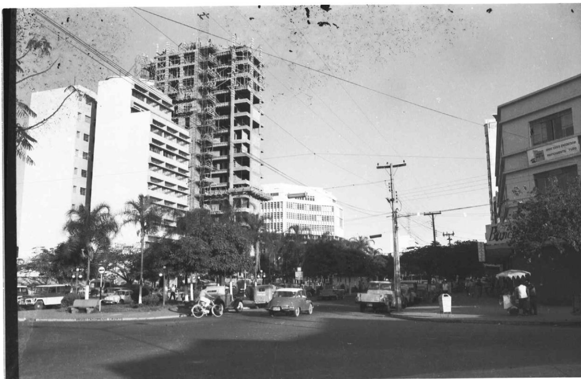
Figura 43. Panorama da Construção do Edifício Minas Bank – Final da década de 1960.
