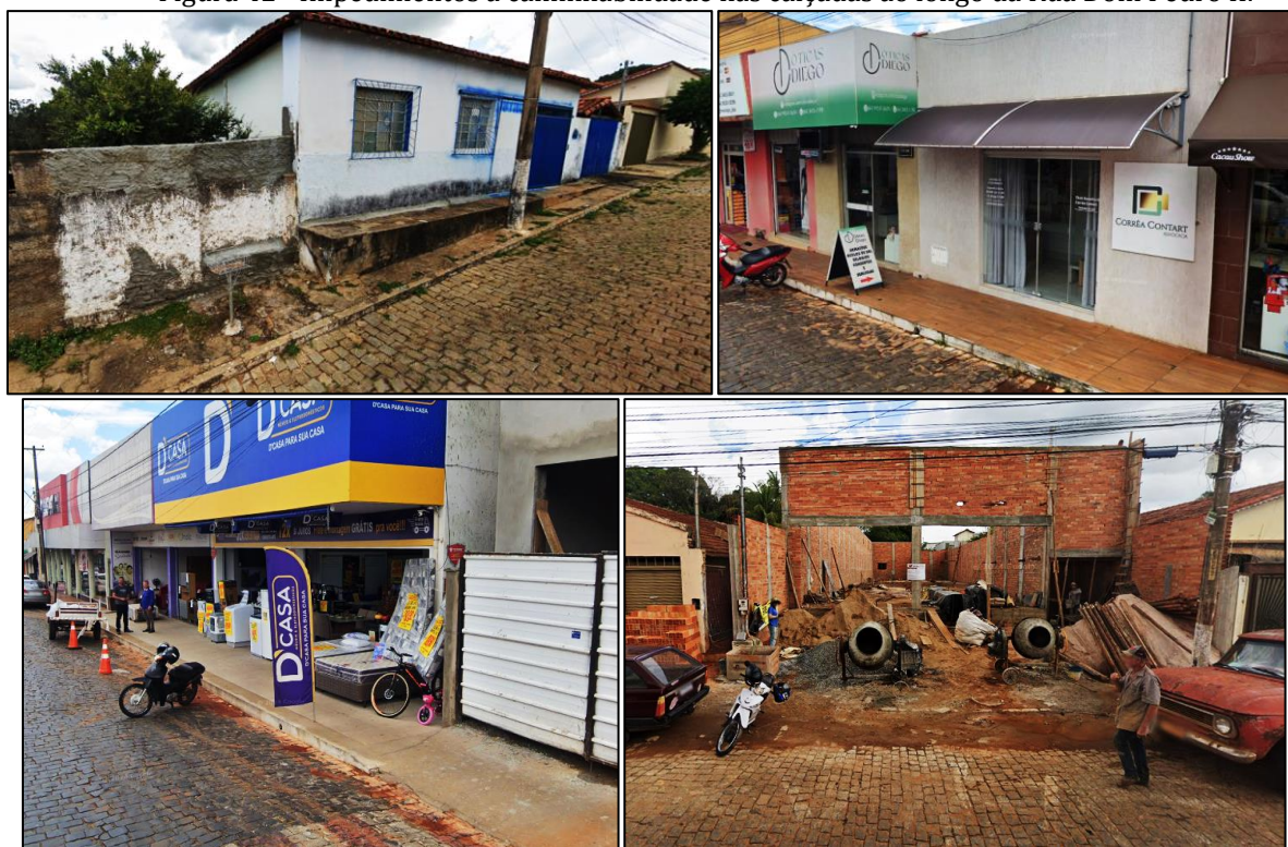
Figura 42 - Impedimentos à caminhabilidade nas calçadas ao longo da Rua Dom Pedro II.
