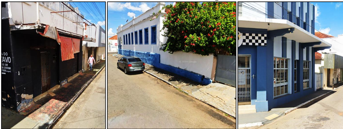
Figura 33 - Unidades de sombreamento ao longo da Rua Barão do Rio Branco.
