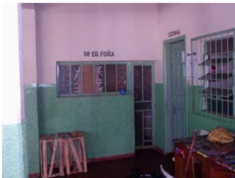
Detalhe do prédio da escola
