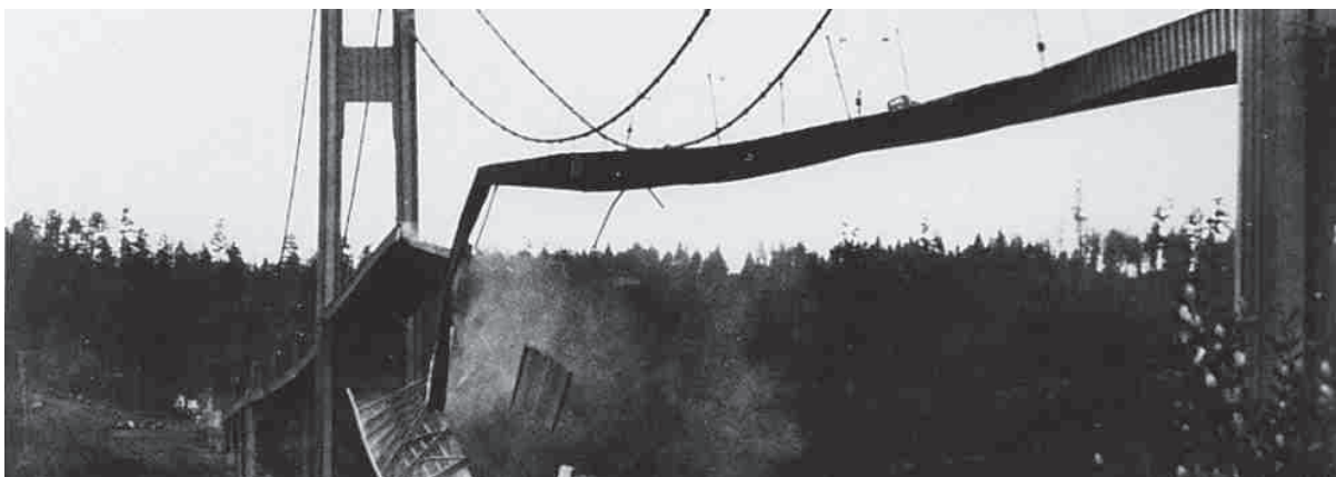
Figura 1.2 - Ponte sobre o Estreito de Tacoma sob ação de ressonância.
